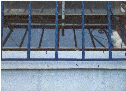
Foto 3: Sustitución de vidrios en módulo de aulas No. 1
