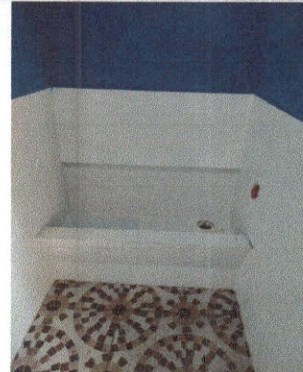
Foto 8: Sustrucción de azulejo en módulo de baños
