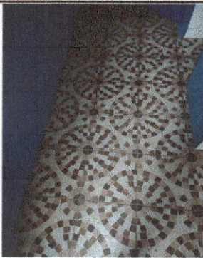
Foto 5: Sustitución de piso cerámico en módulo de baños
